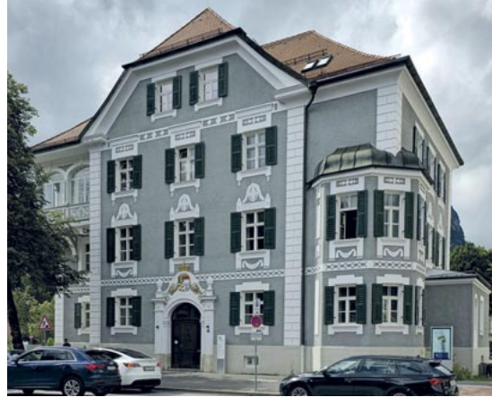
Ehemaliges Finanzamt Garmisch-Partenkirchen
